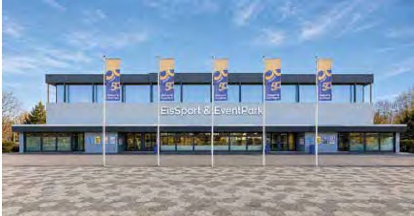
Abb. 40: Renovierte Außenfassade der Eissporthalle (2025).
